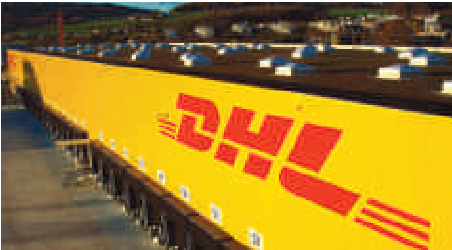
Abbildung 2.20 Logistikanlage Quelle: DHL Schweiz
