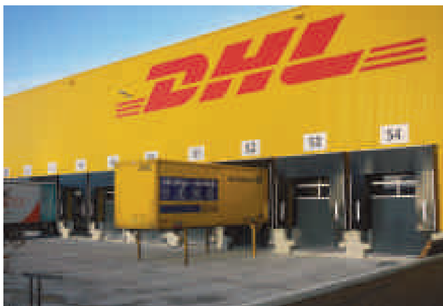
Abbildung 3.11 Logistikanlage DHL Freight & Express Regensdorf Quelle: Rapp Trans AG
