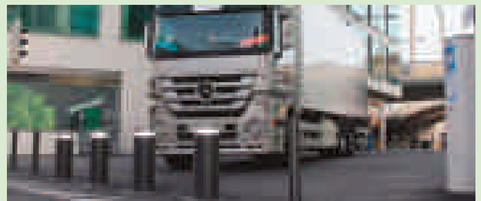
B2.3 Zutrittssystem Primetower, Zürich
