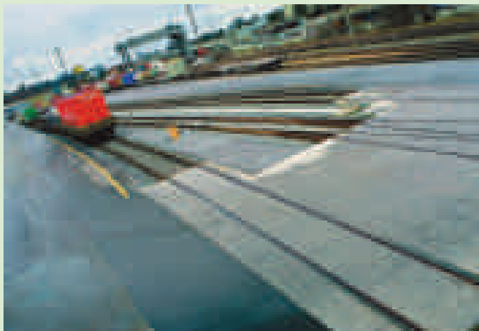
E2.2 Gleisanlage Güterbahnhof Wolf
