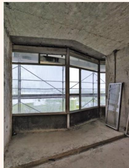
Der Umgang mit der Nordfassade funktioniert anders. Hier hat man es mit einem skulpturalen Betongerippe zu tun, in das eine Vielzahl von Einzelfenstern montiert wurde. Diese «Gitter» kann man nicht wärmetechnisch isolieren, ohne die ganzen Proportionen zu stören und damit die denkmalgeschützte Fassade zu verändern. Deswegen wird die Glasebene um 6 cm nach hinten verschoben, hinten wird ein Rahmen auf das Betonelement gebaut.
