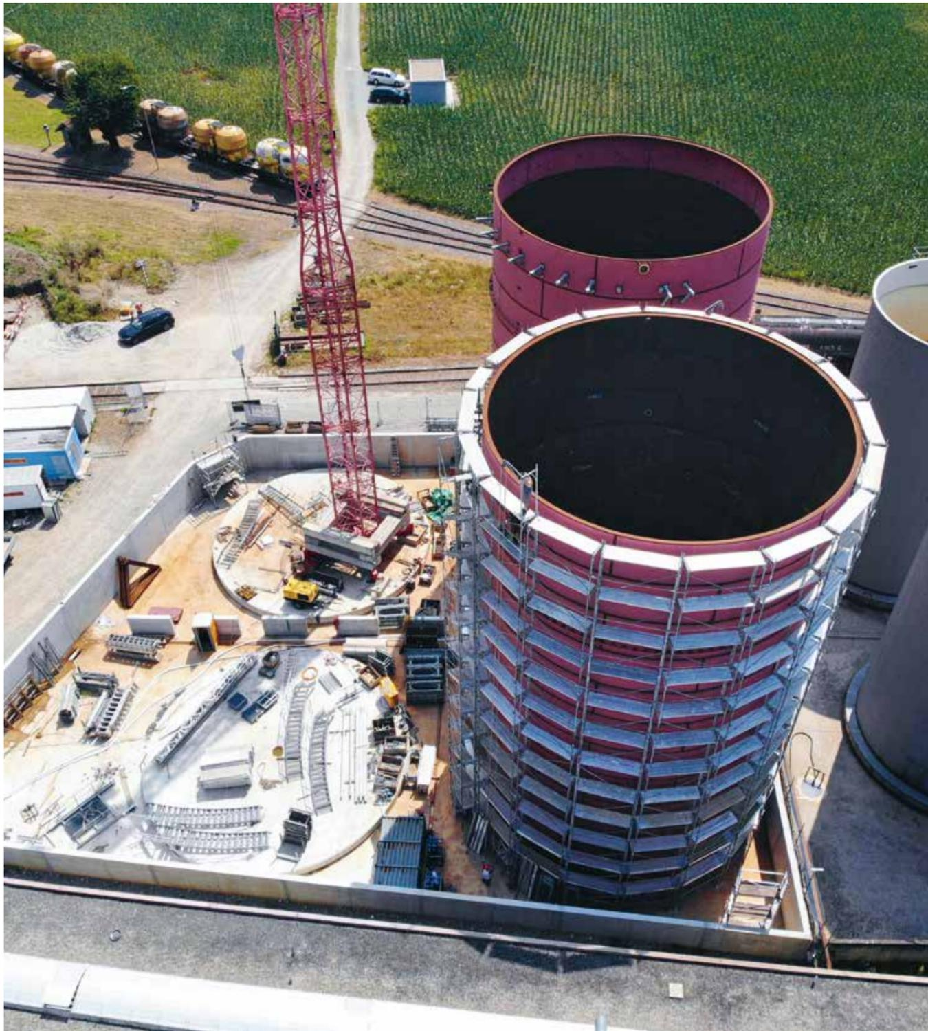
Tank 1 mit Aussengerüst für die Aussenbeschichtung
