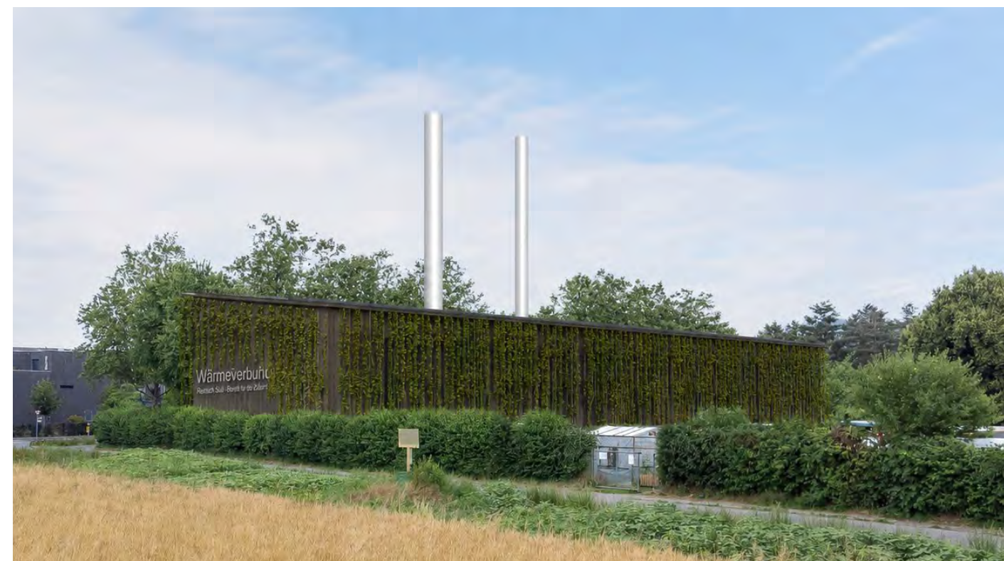
Heizzentrale Wärmeverbund Reinach
