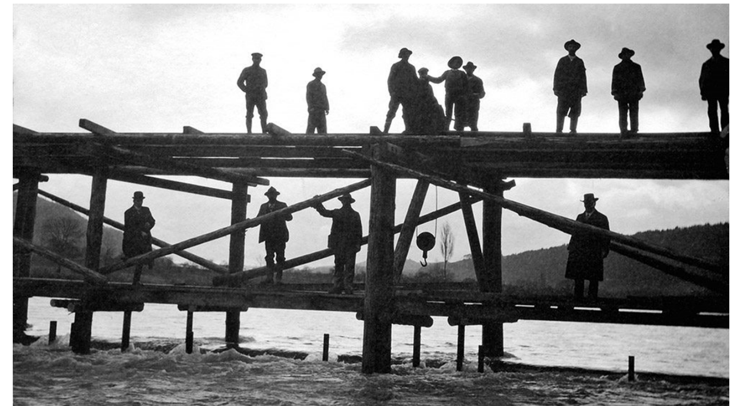
Originalfoto Rapp: Einlassung einer Rohrleitung in den Rhein (1916) – rechts unten Wilhelm Rapp-Müller.
