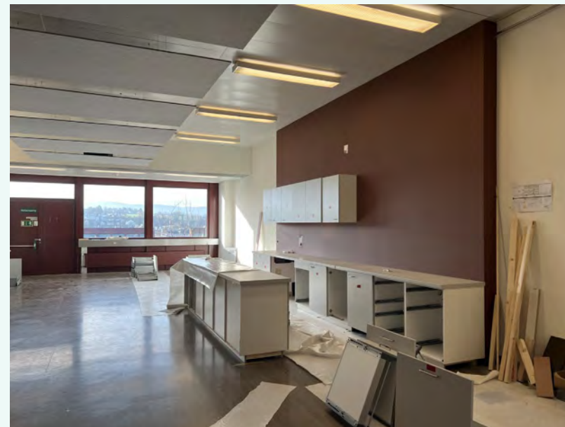
Küchenelemente sowie Akustikabhängungen vom H100 ziehen ins Penta Space
