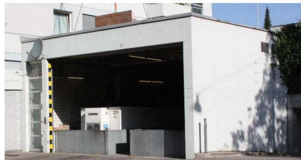
Abbildung 31: Abgeschlossener Anlieferbereich bei geöffnetem Tor
