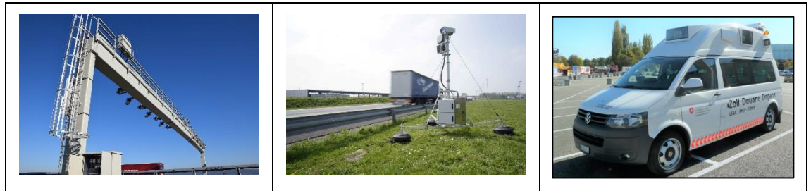
Abb. 7: Links: Stationäre Kontrollanlage LKW-Maut Österreich (Kameras, Scanner, DSRC) Mitte: Versetzbare Kontrolle LKW-Maut Belgien (Kameras, Scanner, DSRC) Rechts: Mobile Kontrolle der LSVA (Kameras, DSRC Antenne hinten am Dach)
